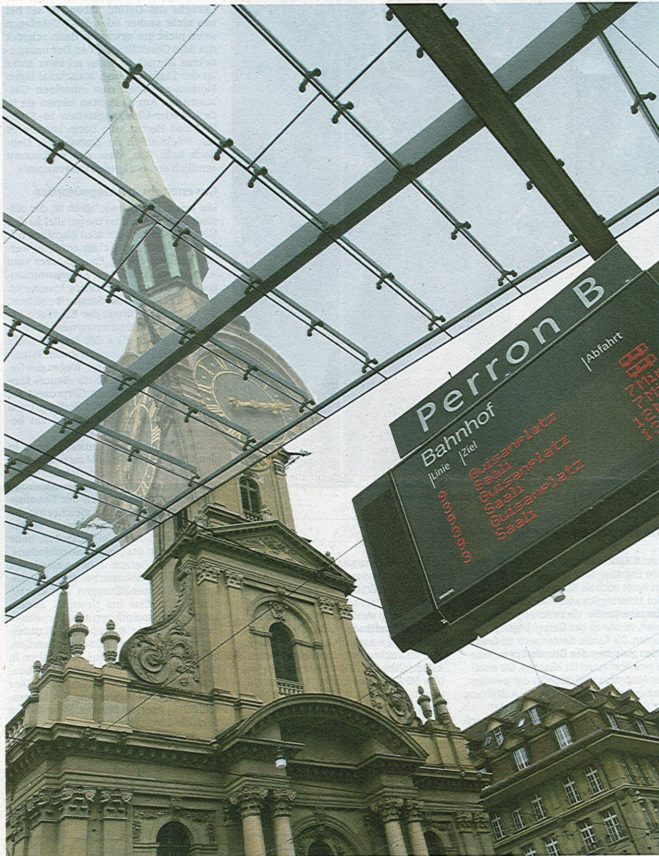
Die geringfügig verzerrende Wirkung des Glasdaches ist von gewissen Standpunkten aus recht gut sichtbar. Foto: Michèle Lüthi
