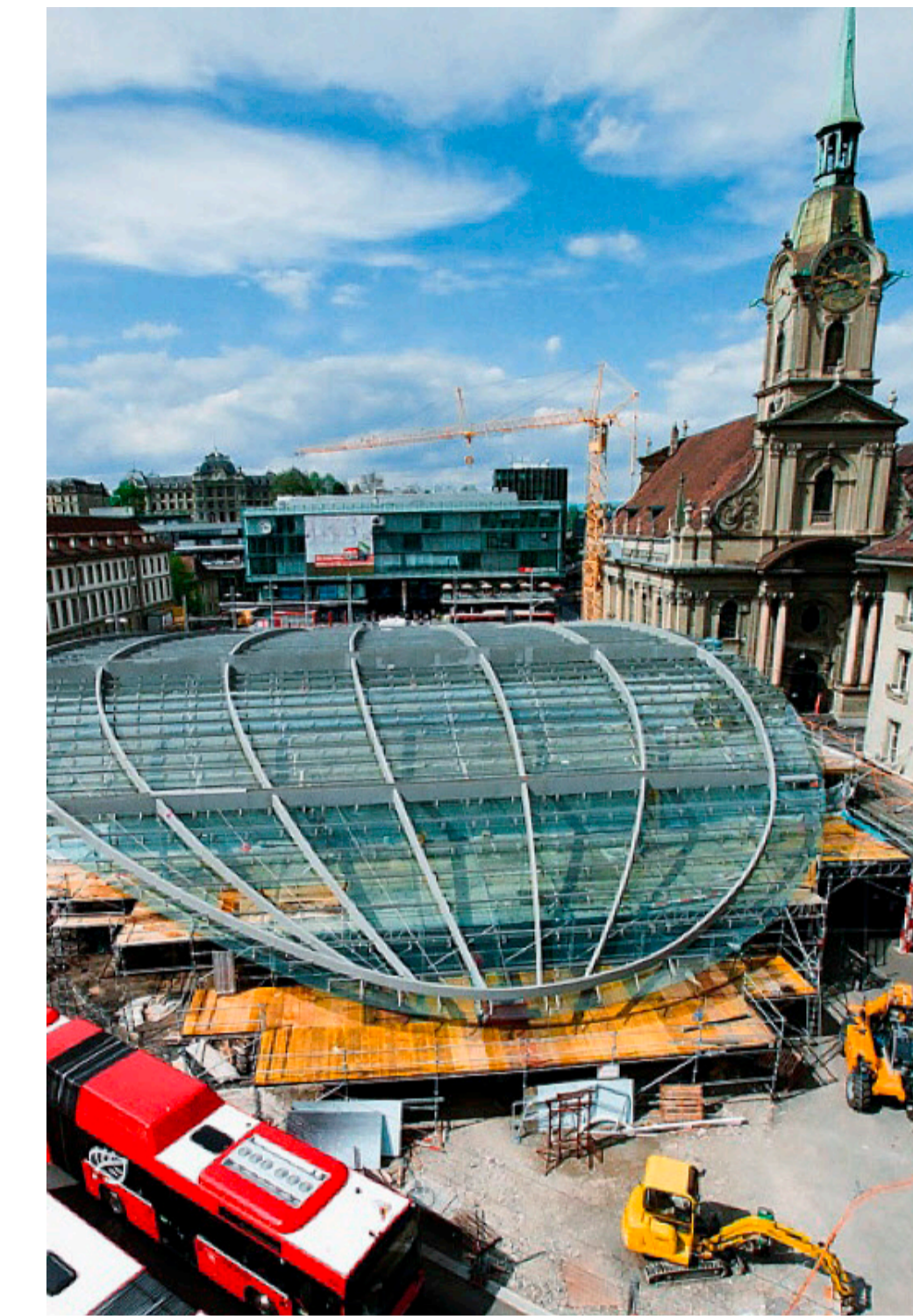
Der Baldachin aus 230 Tonnen Stahl und 2350 Quadratmetern Glas entsteht.
